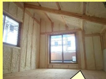
発泡ウレタンの断熱材を充填し、外気温をしっかりと遮断します。
